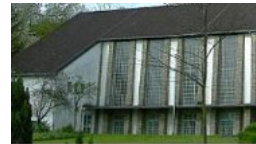
Evangelische Gemeinderäume Ludweilerstr. 62 66333 Völklingen - Wehrden/Geislaubern
