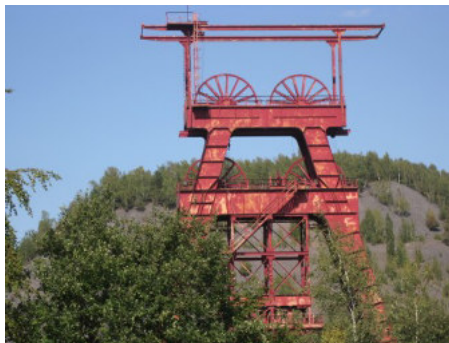
Förderergerüst der Grube Ste Fontaine.
