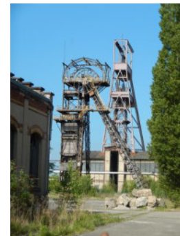
Förderergerüst der Grube Simon, Forbach.
