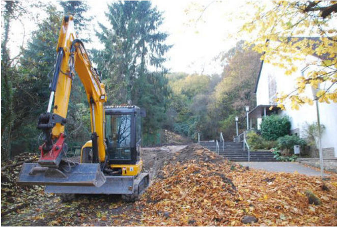
Bild: Vorbereitung des Geländes für die Errichtung des barrierefreien Zugangs zur Auferstehungskirche.
