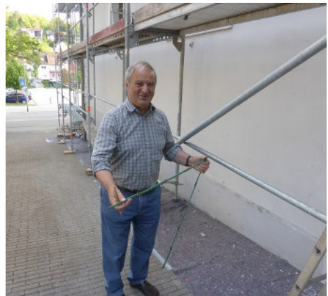
Dipl.Ing. Architekt Herbert Hecht begleitet die Renovierungsarbeiten. Bild: Roland Mollet
