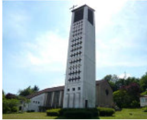
Evangelische Auferstehungs- kirche Ludweilerstr. 62 Wehrden / Geis- launern
