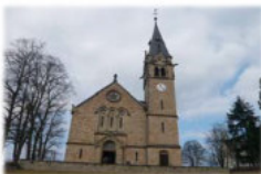
Evangelische Kirche Karlsbrunn Fröbelweg / Jahnstraße Karlsbrunn
