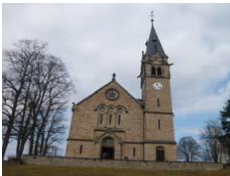
Evangelische Kirche Karlsbrunn Fröbelweg / Jahnstraße Karlsbrunn
