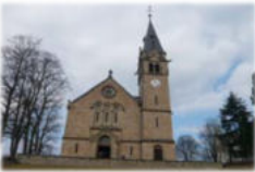
Evangelische Kirche Karlsbrunn Fröbelweg / Jahnstraße Karlsbrunn
