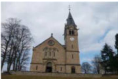
Evangelische Kirche Karlsbrunn Fröbelweg / Jahnstraße Karlsbrunn
