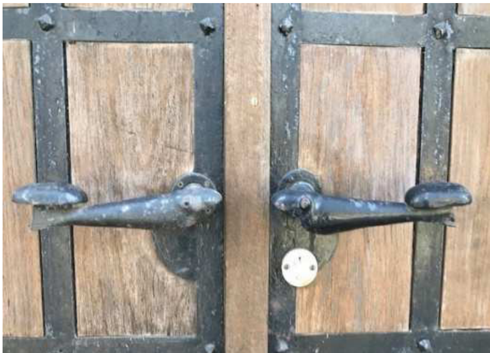
Türgriffe am Haupteingang der Auferstehungskirche.
