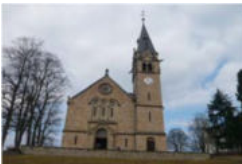
Evangelische Kirche Karlsbrunn Fröbelweg / Jahnstraße Karlsbrunn
