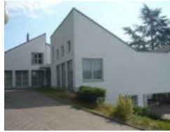
Johannes-Cal- vin-Haus Völklinger Straße 90 Ludweiler
