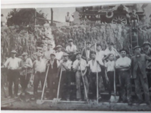
Fleißige Gemeindeglieder bei Ausschachtungsarbeiten
