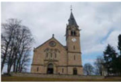
Evangelische Kirche Karlsbrunn Fröbelweg / Jahnstraße Karlsbrunn
