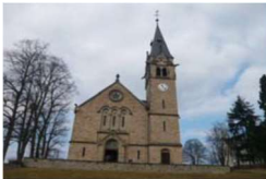
Evangelische Kirche Karlsbrunn Fröbelweg / Jahnstraße Karlsbrunn
